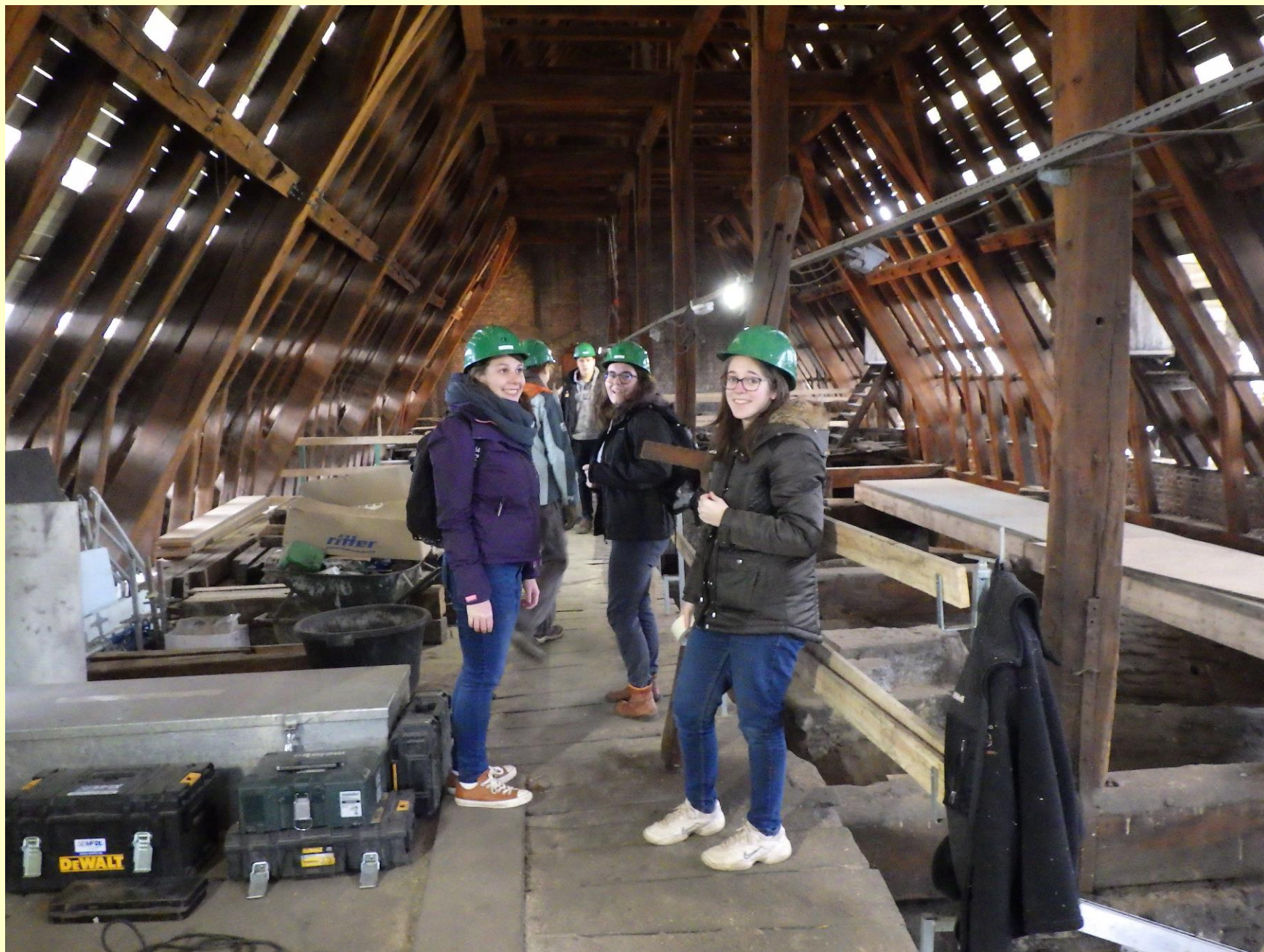
Exercices sur des chantiers de restauration
